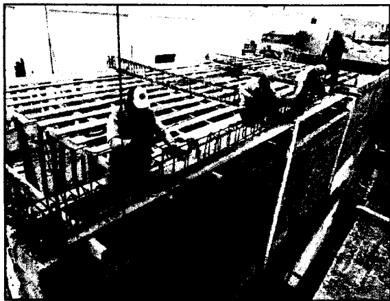
Foto N° 05 y 06: : Area de Talleres: armado y vaciado de losa aligerada.
