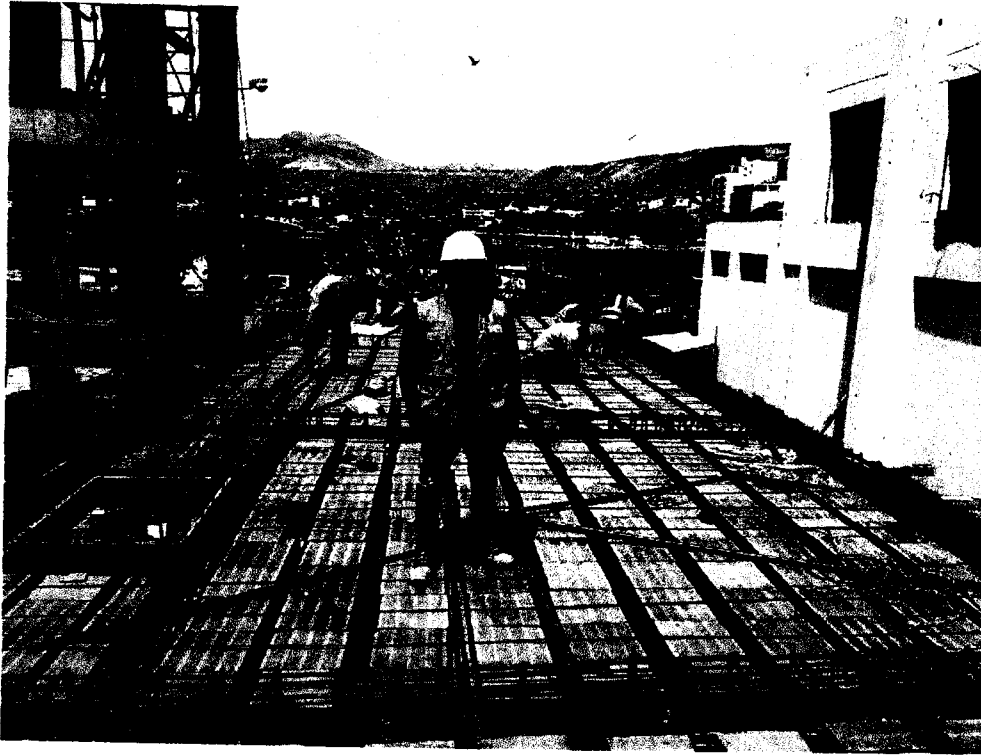
Fig. 01 Losa aligerada del área de talleres con instalaciones eléctricas y sanitarias
