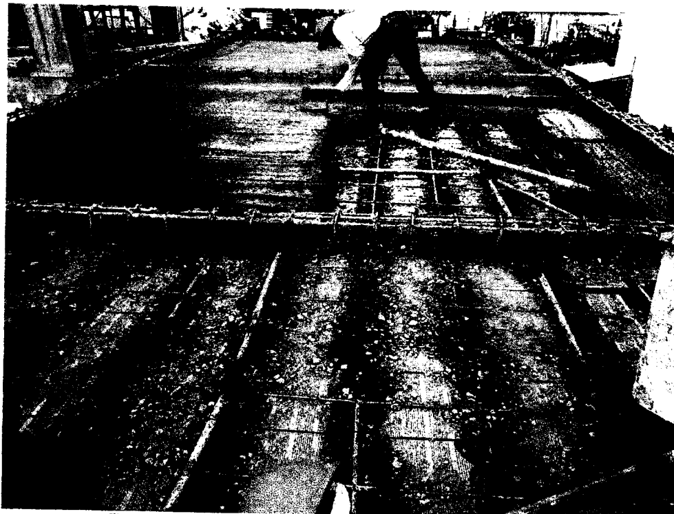
Fig. 02 Habilitación de acero f_y=4200 kg/cm 2 y encofrado para vigas del tanque elevado
